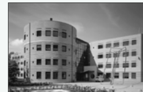
1990 Office centre 'Citadel' J. Dekkers
