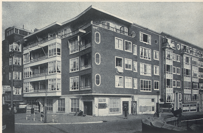
23. Particuliere woningbouw Sloterkade. Architecten Zanstra, Giesen & Sijmons, 1942
