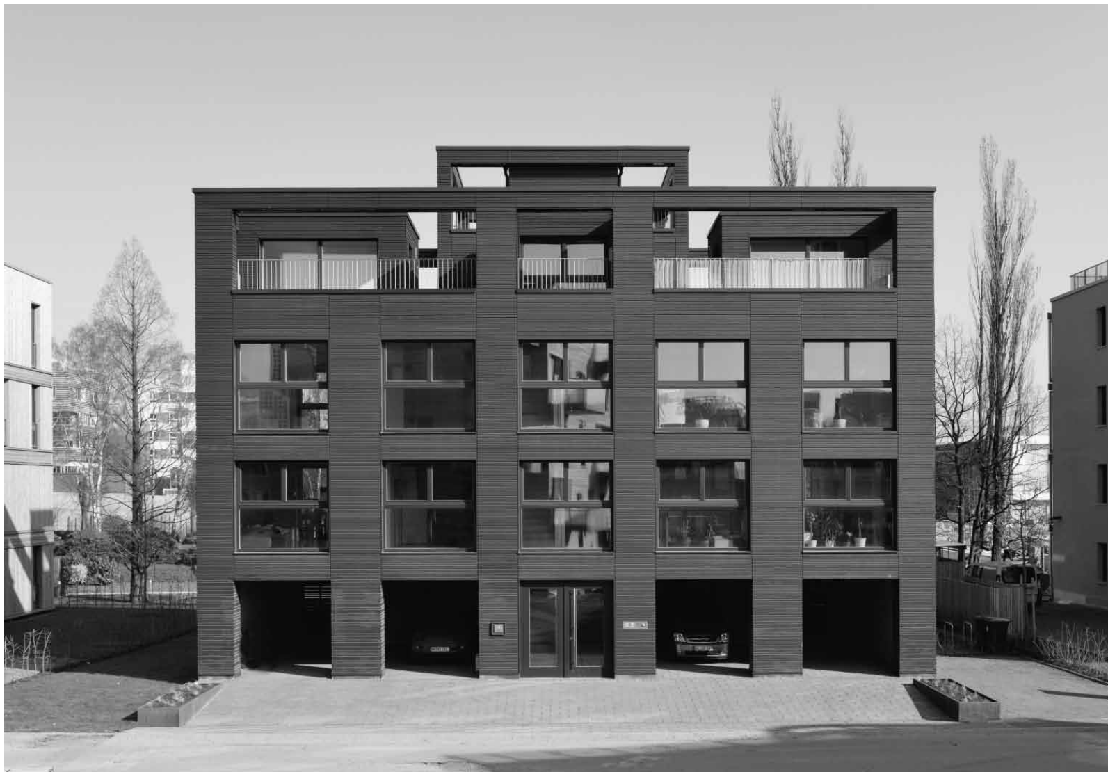
001 Woongebouw Case Study #1, straatgevel
