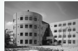
1990 Office centre 'Citadel' J. Dekkers
